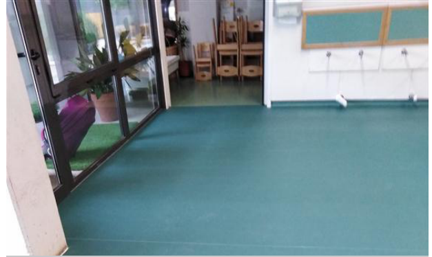
Paviment escola bressol Moisès
