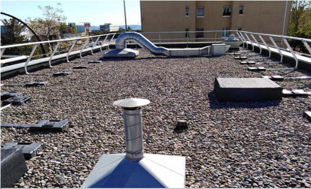
Seguretat coberta escola bressol Moisès
