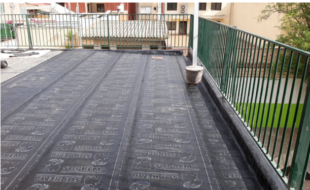
Impermeabilització a l'EBM Tabalet
