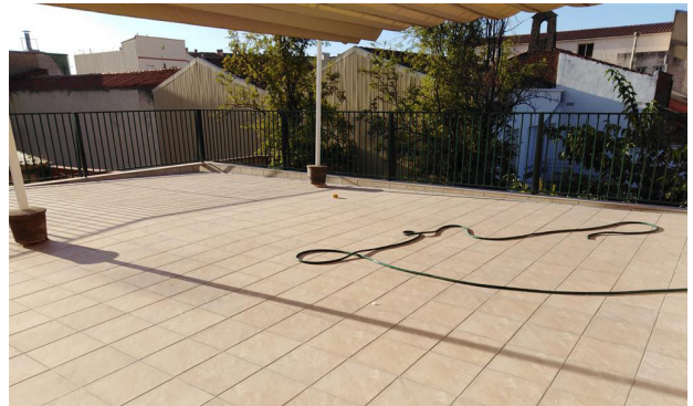
Impermeabilització a l'EBM Tabalet
